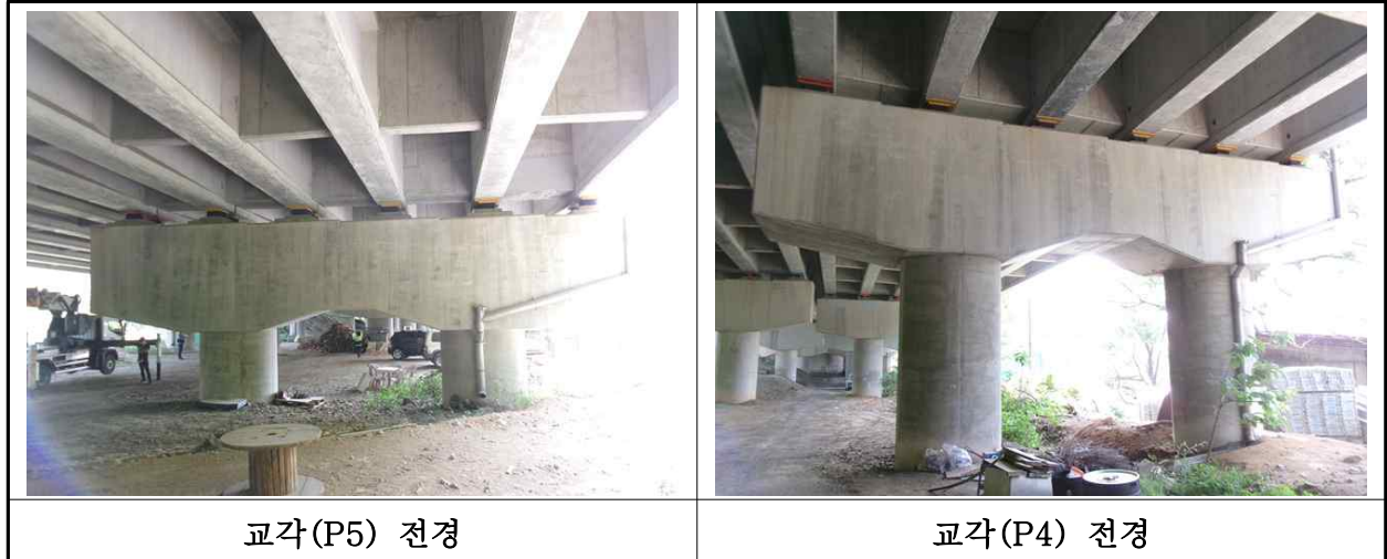
【사진 2.3.10】 교각 전경
