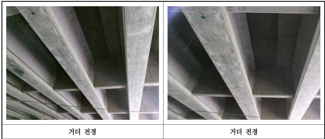
【사진 2.3.4】 거더 전경
