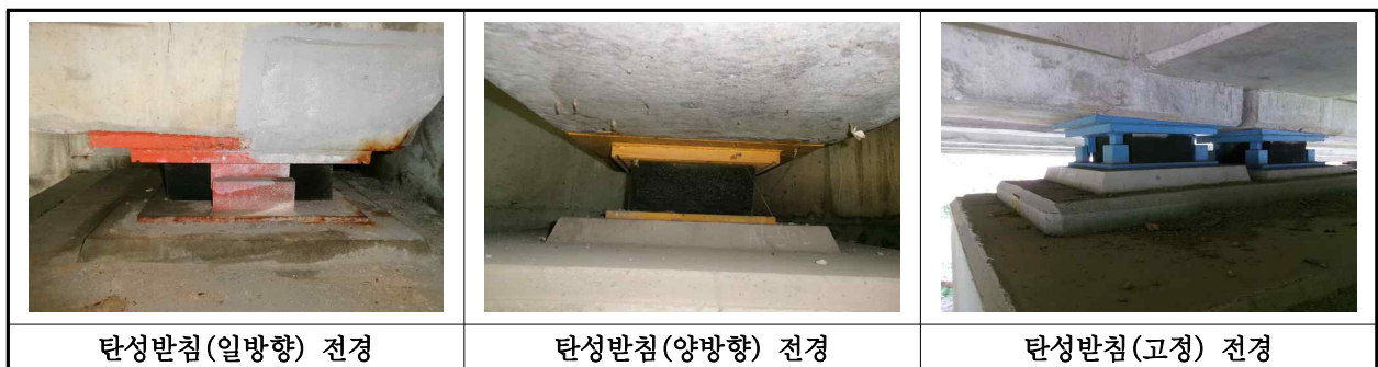
【사진 2.3.14】 교량받침 전경
