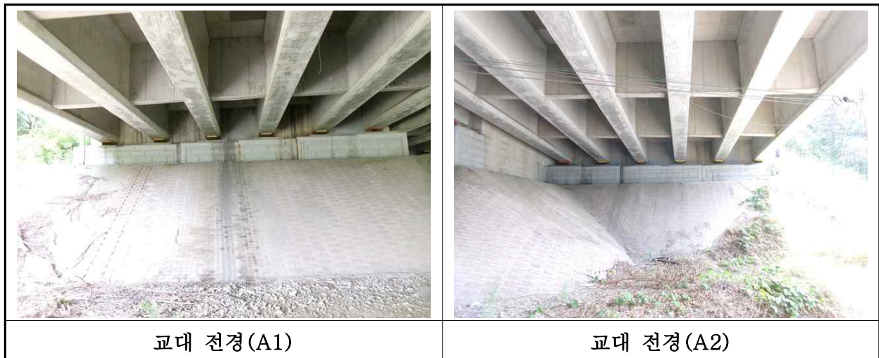
【사진 2.3.8】 교대 전경
