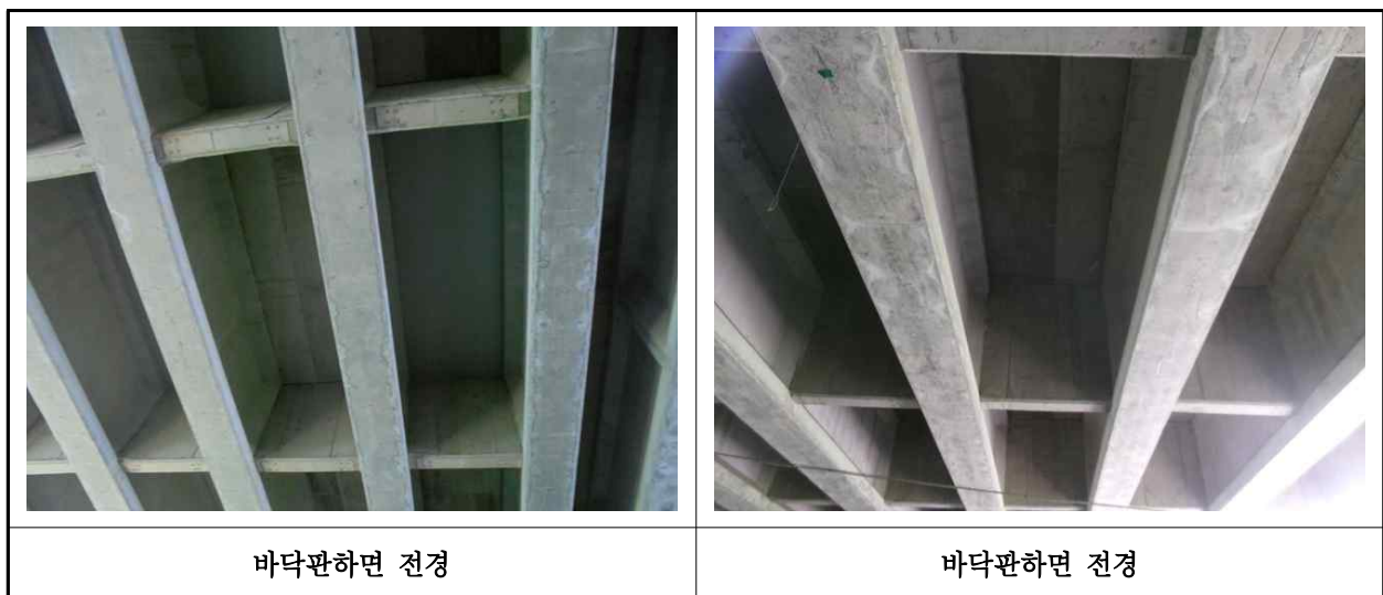
【사진 2.3.2】 바닥판하면 전경
