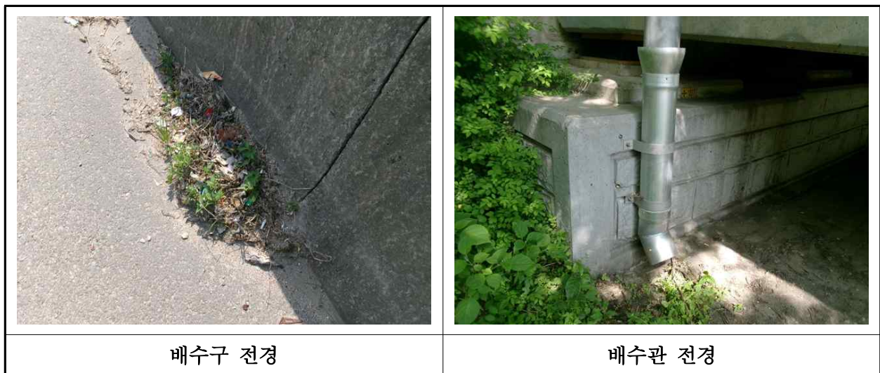
【사진 2.3.23】 배수시설 전경
