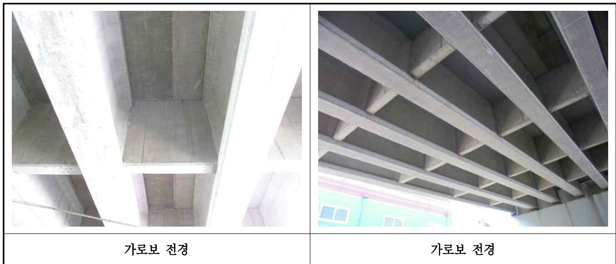
【사진 2.3.6】 가로보 전경
